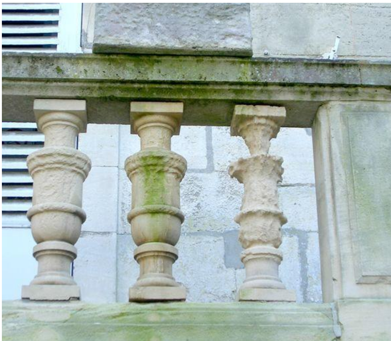
Détail des balustres en pierre de l'escalier.
