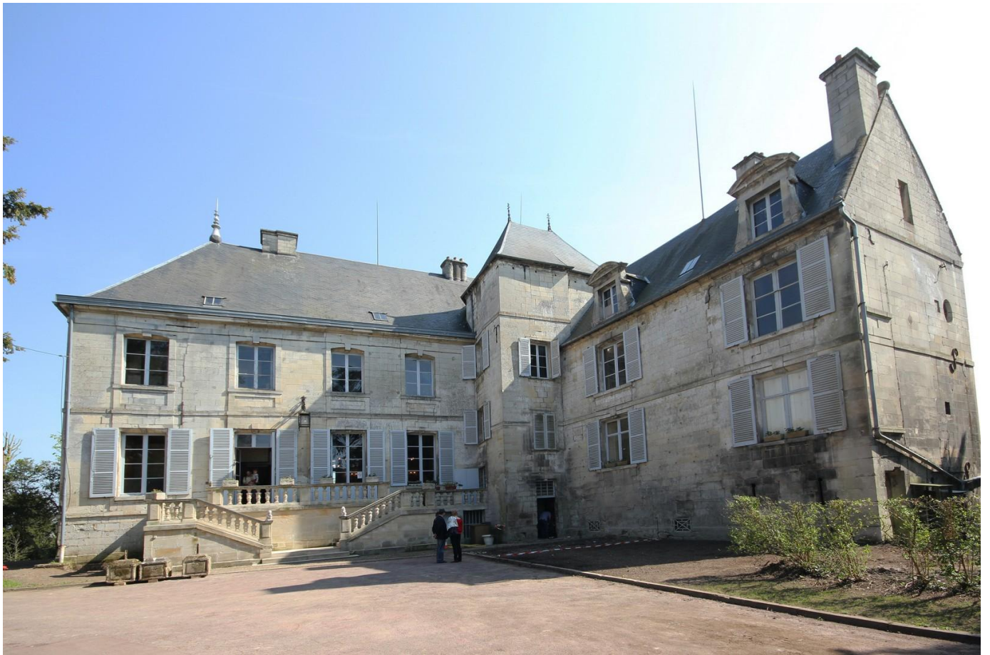
Escalier 17e siècle et façade nord.
